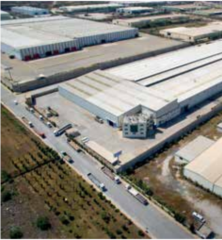
Yücel Boru Fabrika - Osmaniye Yücel Boru Factory - Osmaniye
